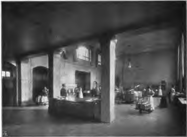
Abb. 140. Kochküche im Krankenhaus Westend.
